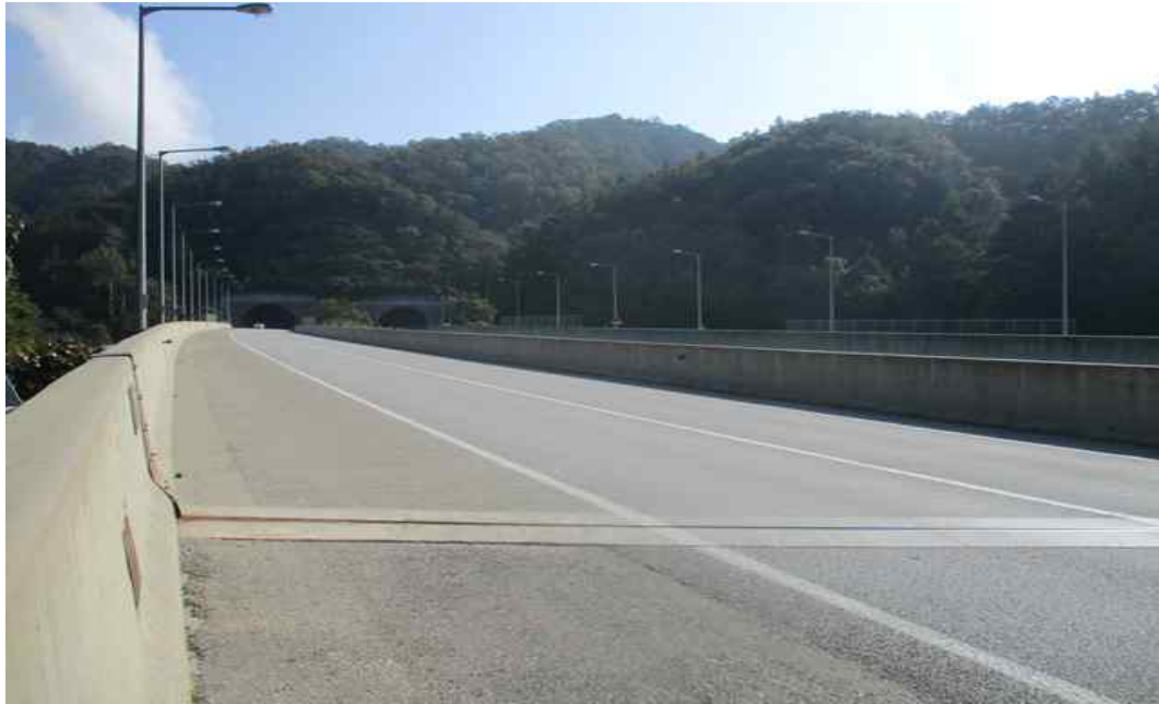
군자4교(서울) 상부 전경
