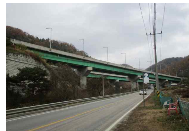
군자4교(양양) 측면 전경
