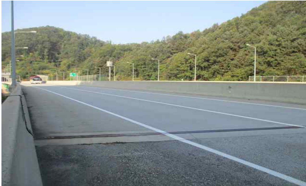
군자4교(양양) 상부 전경
