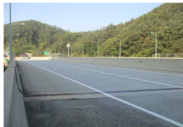
군자4교(양양) 상부 전경
