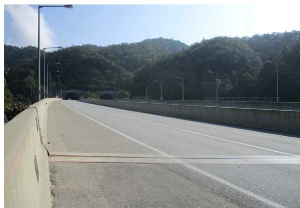
군자4교(서울) 상부 전경
